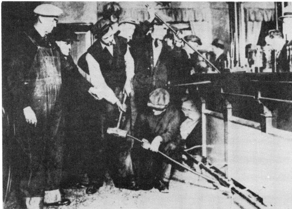
Obr. 4. Demolice tajného baru v New Yorku ve stejné době
